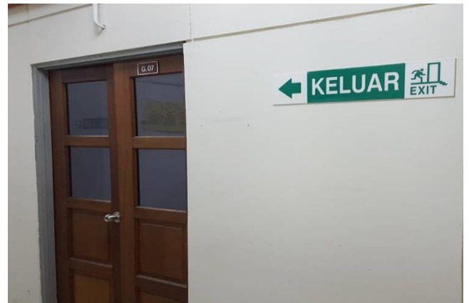
Laluan/ Tangga Kecemasan
